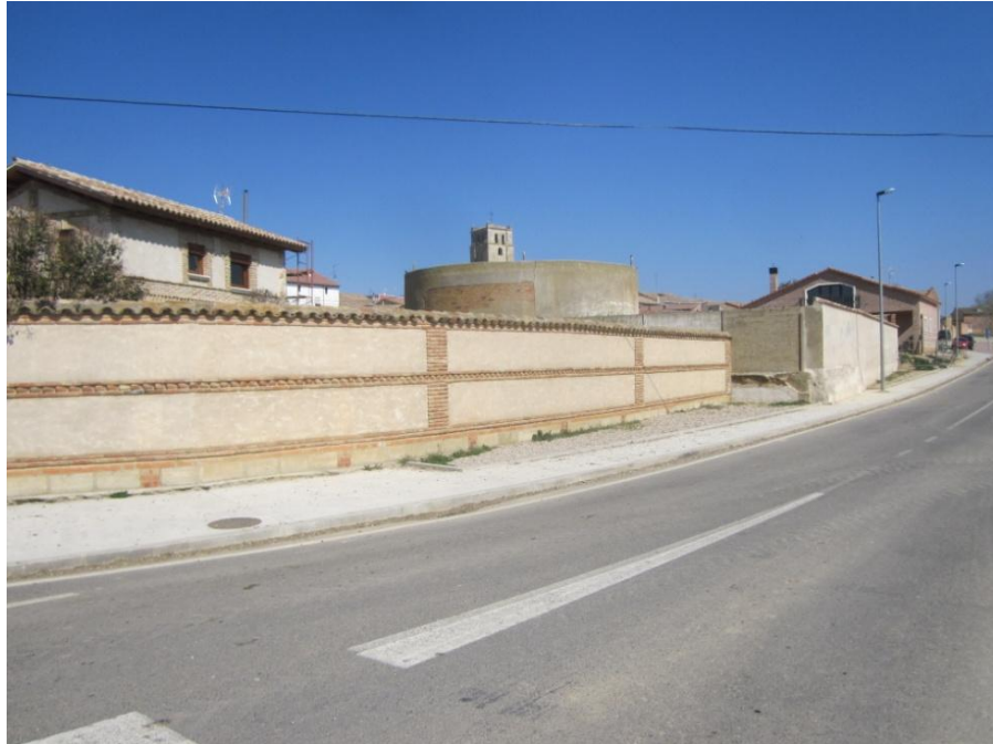
VISTA MANZANA DESDE LA CARRETERA DE VILLAUMBRALES A VILLAMARTÍN
