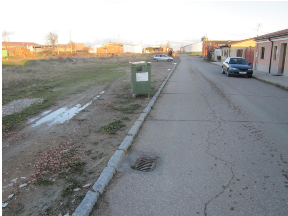
VISTA CALLE DE LA CAMPANA. PARCELA SITUADA A LA IZQUIERDA
