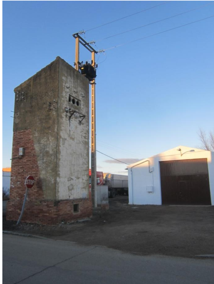
VISTA ALMACÉN MUNICIPAL Y TRANSFORMADOR
